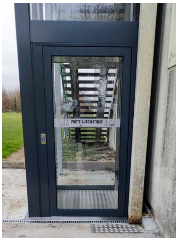
Monte-personnes au gymnase n°1 (réalisé par une entreprise)
