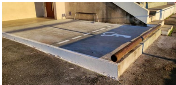
Création d'une plate forme pour handicapés au stade de foot
