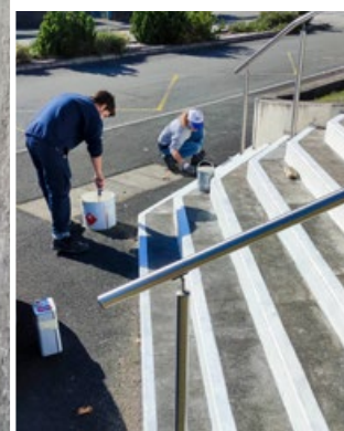
Peinture des contremarches autour de la mairie
